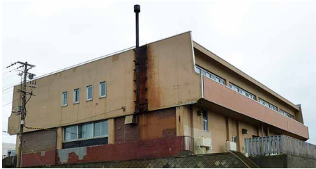
▲老朽化している福祉会館
