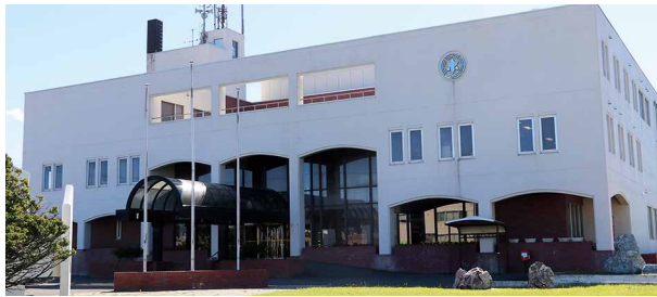
▲ 40年以上経過している施設（役場庁舎）
