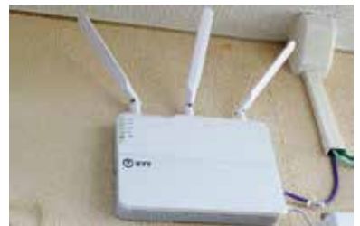
▲Wi-Fi 通信機器（役場）
