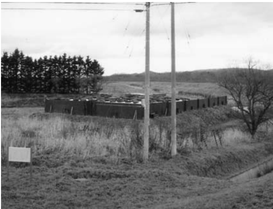
雄信内にある鋼製仮設用バンカー
