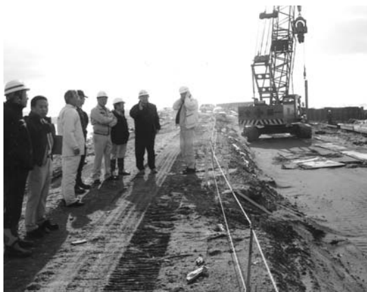
北導流堤・港湾災害の現場
