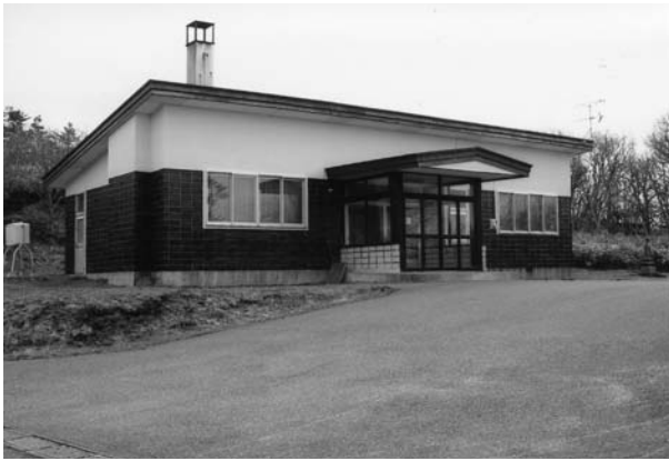
▲築35年が経過した火葬場
