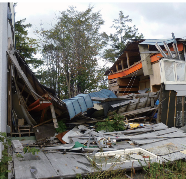
▲春先に損壊した旧円山小学校体育館器具庫
