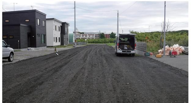
町で砂利道に道路や駐車場の整備に使うアスファルト再生砕石(RC)を敷き、重機で締め固める工事を行い、住民が砂ぼこりを気にせず窓を開けられるようになりました。
