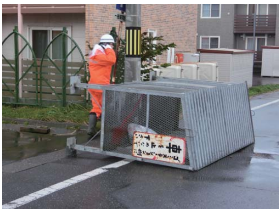
▲強風により横転したゴミステーション
