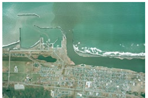
▲施設整備の充実が望まれる天塩港
