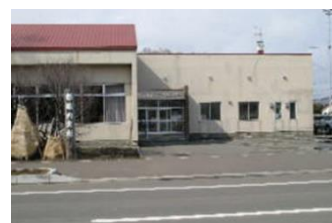
雄信内生活改善センター
