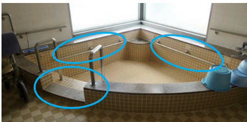
▲縁の切り下げ・手すりの設置が行われた病院の浴槽
