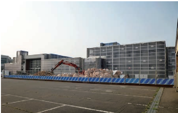
▲夕映（本館・新館）の改修工事
