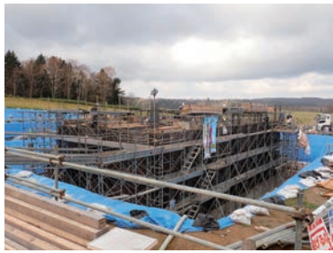
▲泉源浄水場の建設工事
