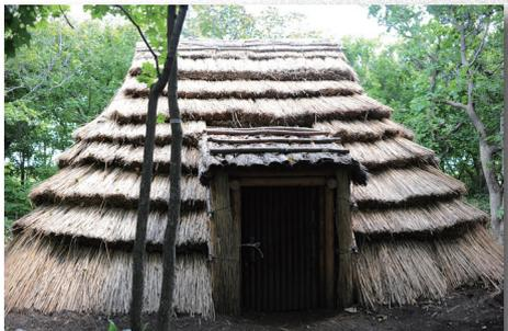
ち委員は延べ63人が作業に参加しました。特に終盤の工程であった屋根の葺き替えは、葺の束を均一にしながら、特定の部分ごとに長さや厚さを微調整していくこと、葺が束ごとにしつかりと住居の骨組みに縄で縛り固定させていくことが、非常に苦勞しました。それ故に、完成したときの達成感は、ひとしおでした。
