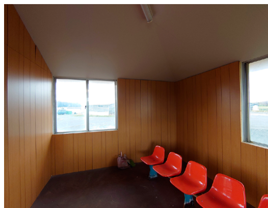
▲改装進行中の待合室の壁
