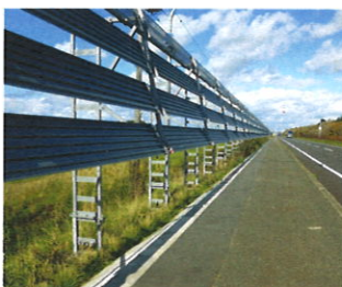
▲国道232号の防雪柵
