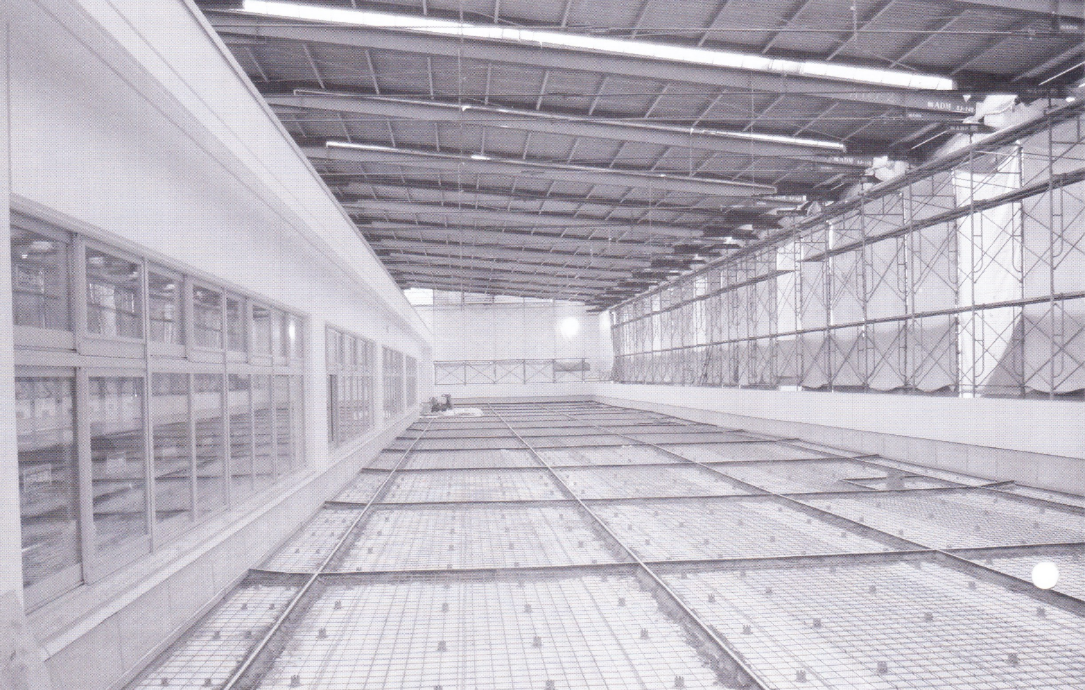
▲完成間近の天塩小学校施行状況（屋上部分）
