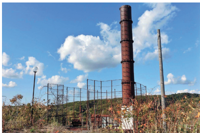
▲旧南川口処理場
