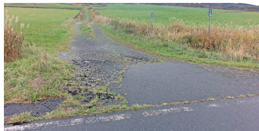
▲道路と草地などを結ぶ取付道路
