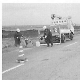
▲町道の維持補修
