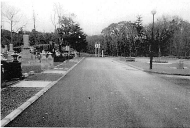
▲天塩町霊園新区道路舗装事業
