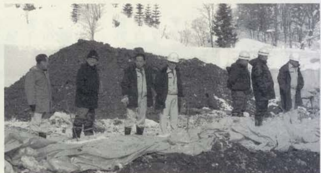
災害復旧工事の状況を調査
