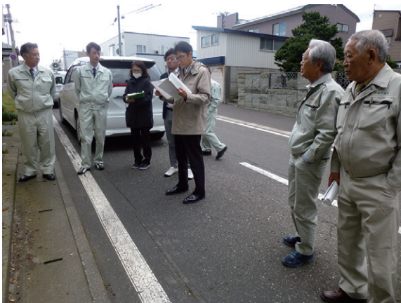
▲危険な空き家を現地調査
