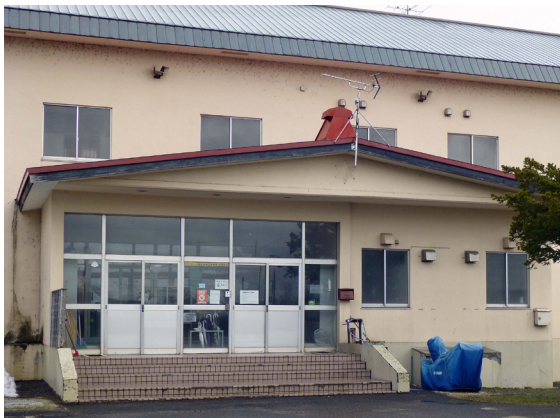
▲避難所機能を有する啓徳小学校
