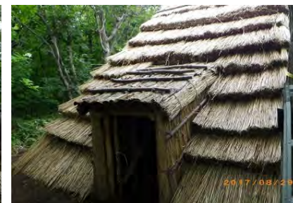
屋根葺き替え完成
