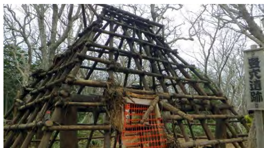
15年前に葺き替えた屋根を剥がした様子
