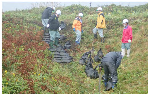
土のうの運搬・設置の様子
