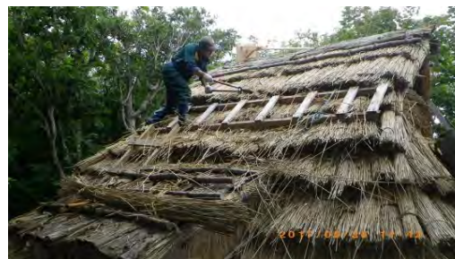
屋根葺き替えの様子
