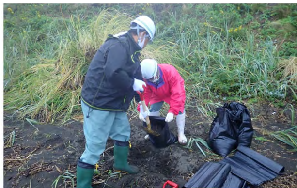
土のう袋へ土砂を入れる様子
