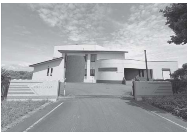
▲天塩クリーンセンター(下水処理場)
